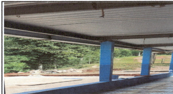
Foto 4: Reparación de columna agrietado en corredor de la escuela.
