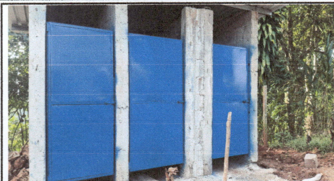
Foto 1: Reparación de servicios sanitarios, debido a que se encuentra en mal estado.
